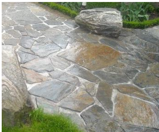
Utwardzenie terenu z łupka szarogłazowego
