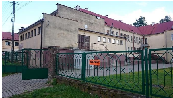
Budynek zespołu szkół (podstawowa i gimnazjum) – w dostatecznym stanie technicznym i estetycznym, wymaga nakładów finansowych na remont dojść do budynku, schodów i elewacji
