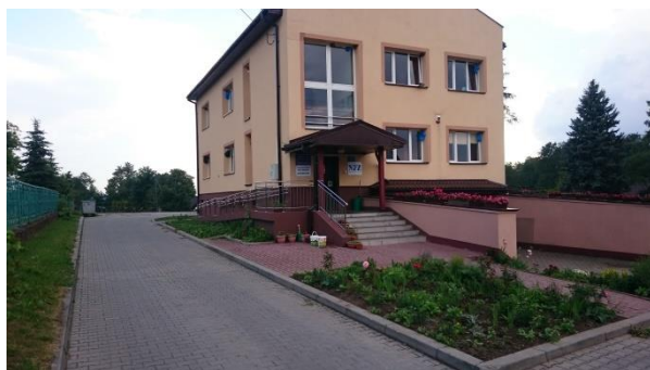
Budynek NZOZ - w dobrym stanie technicznym i estetycznym, zagospodarowanie terenu wokół budynku nie jest integralne z przestrzenią publiczną opracowywanej części miejscowości (podobnie jak budynek GOPS)
