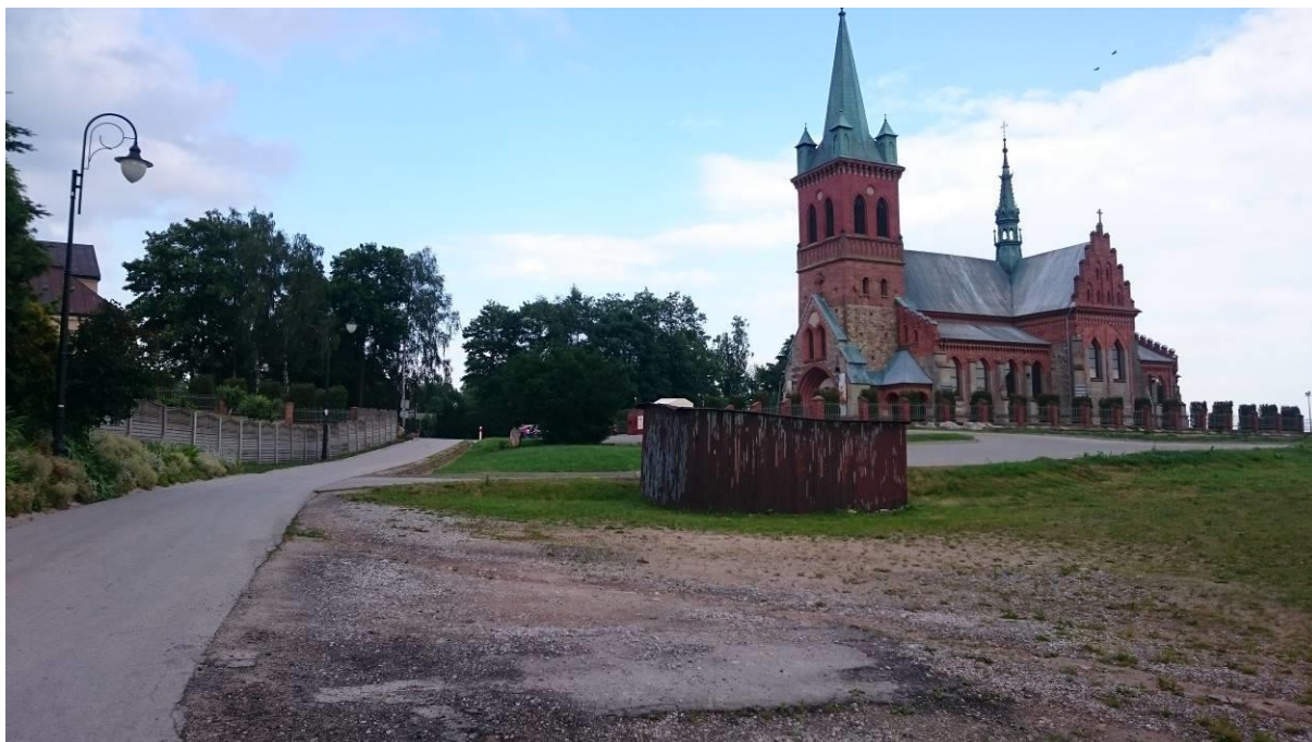
Widok na kościół w Masłowie Pierwszym – teren za parkingiem wymagający kompletnego zagospodarowania terenu
