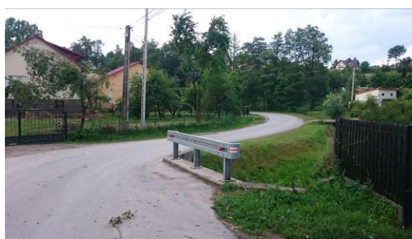
ul. Spacerowa – krety układ drogi dojazdowej, brak poboczy i oświetlenia
